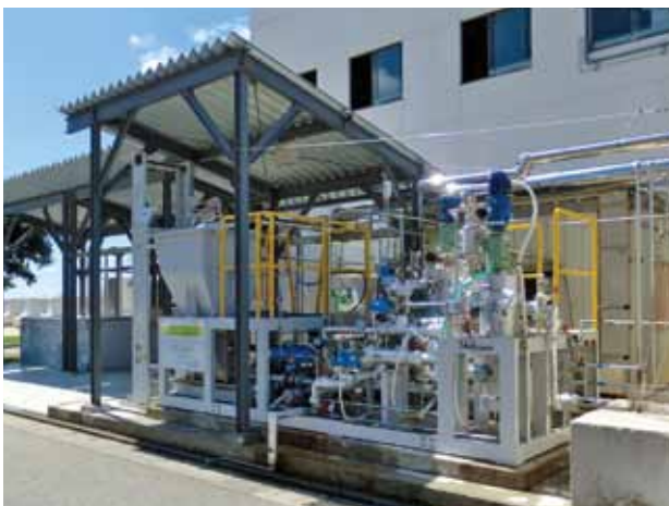
<実証プラントの全体像>
